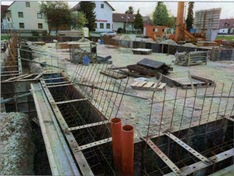
Fundamente für die Außenmauer, April'08
