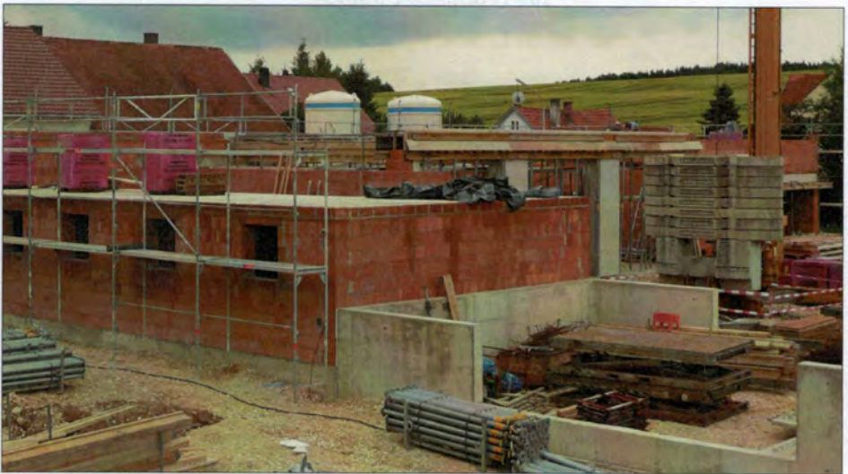
Erstellen des Rohbaus, Mai/Juni'08
