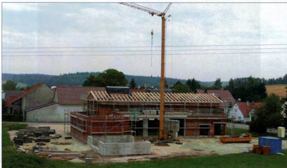
Rohbau mit Dachstuhl, Juli / August '08
