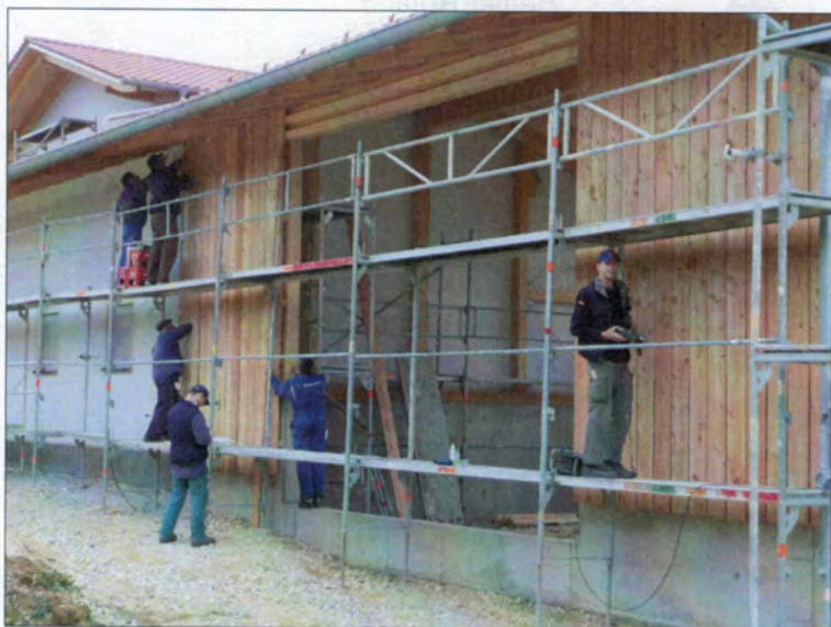
Verkleiden der Lagerhalle
