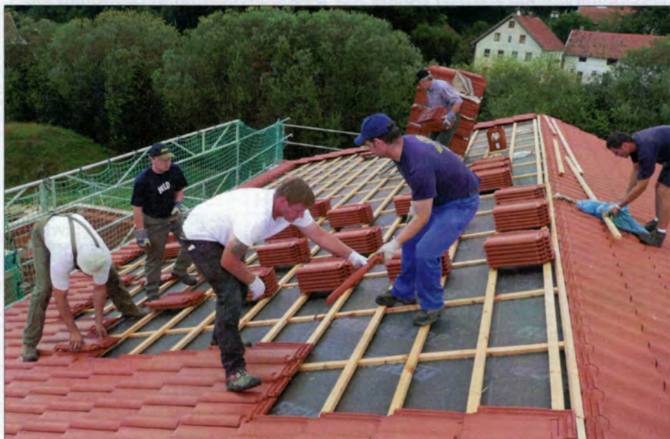
Eindecken des Daches, August '08
